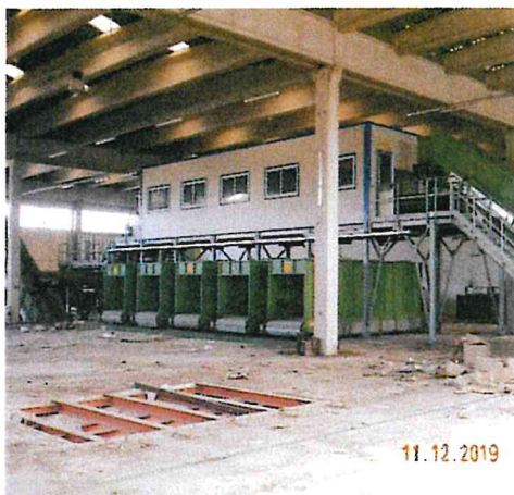
Cabina di selezione - esterno
